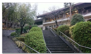
急傾斜地に建つ「清風園」
